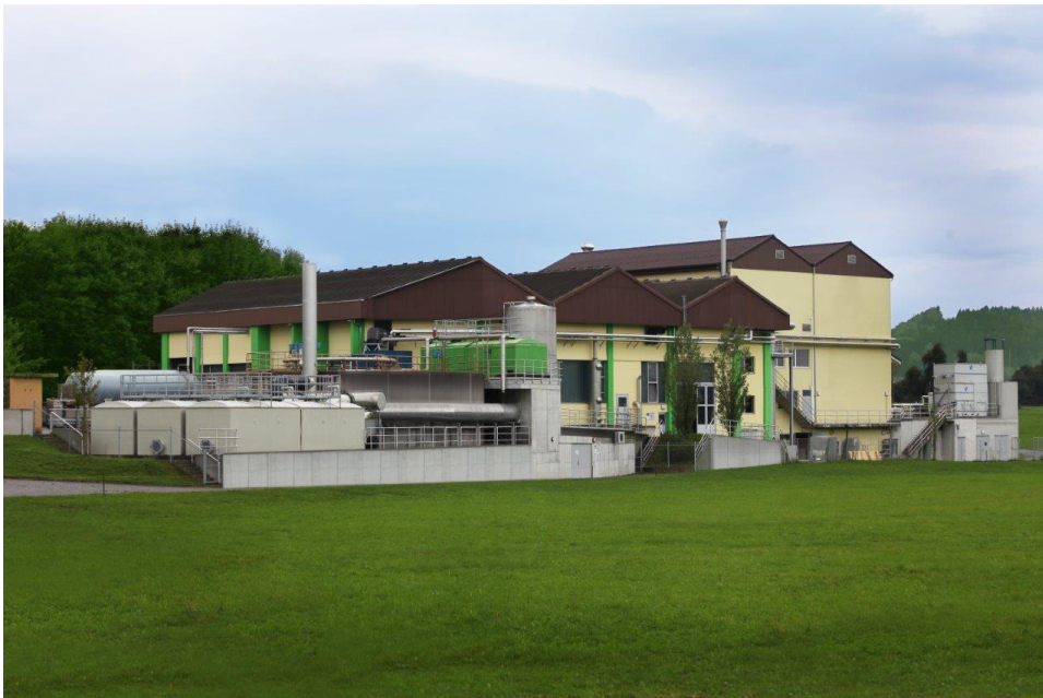
Ansicht der Biogasanlage BIMA aus Nordosten
