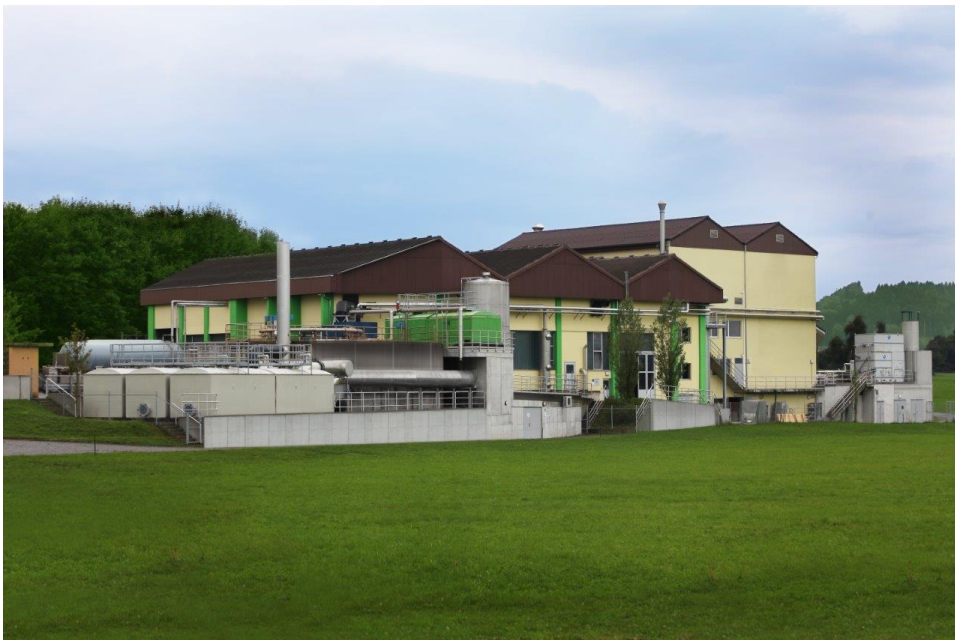
Ansicht der Biogasanlage BIMA aus Nordosten
